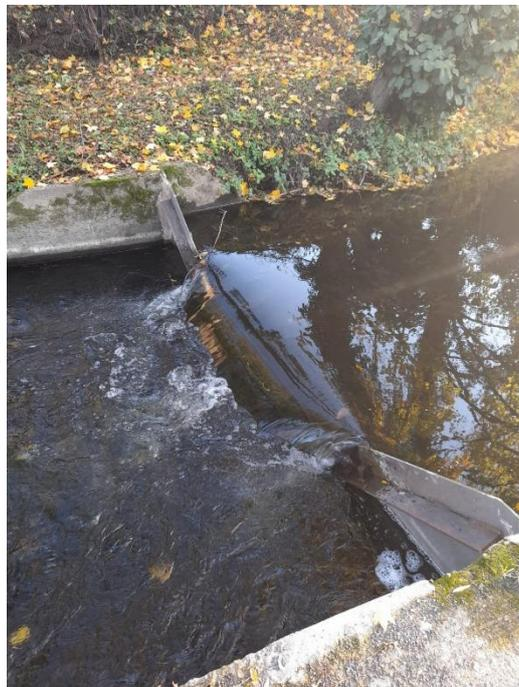
**Figure 105 : Vanne installée par l'OFB en amont du Béal de Lempdes-sur-Alagnon**
