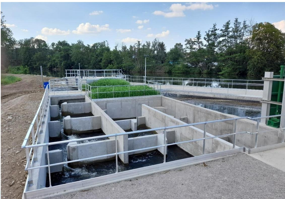
**Figure 70 : Passe à poissons à fentes verticales aménagée au niveau du seuil de Jenzat sur la Sioule (crédit : LOGRAMI, 2021)**
