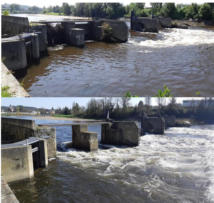
**Figure 133 : Seuil de Descartes sur la Creuse avant (22/07/2021) et après (22/03/2022) l'ouverture des pertuis**
