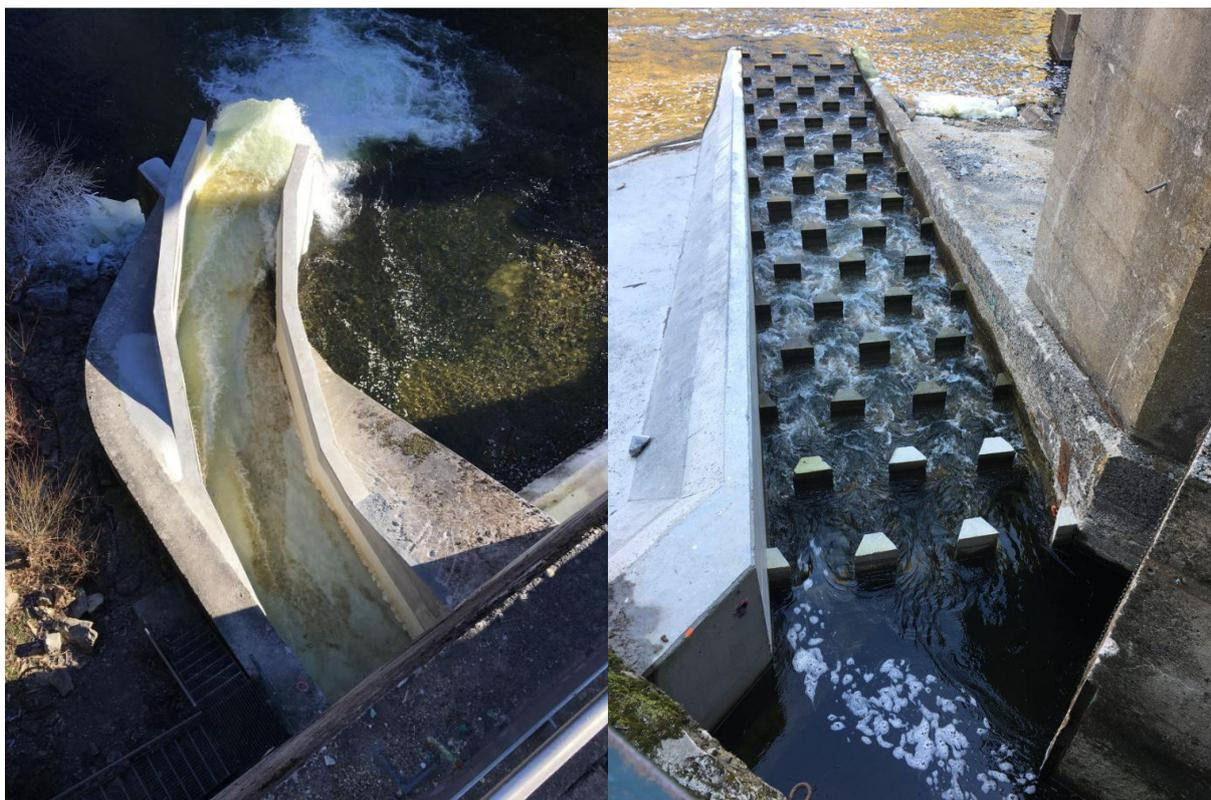
**Figure 68 : Goulotte de dévalaion (à gauche) et passe à poissons (à droite) du nouveau barrage de Poutès sur l'Allier (crédit : LOGRAMI, 2022)**
