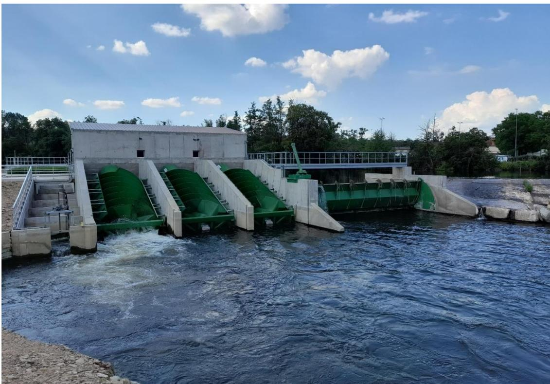
**Figure 69 : Vue aval du seuil de Jenzat sur la Sioule avec de gauche à droite : passe à poissons, vis hydrodynamiques et clapet de décharge (crédit : LOGRAMI, 2021)**
