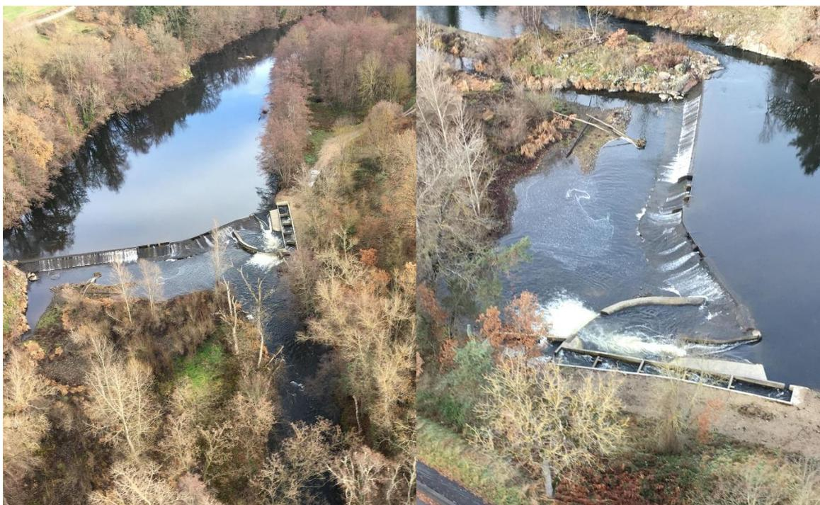
**Figure 66 : Passe à bassins réalisée au seuil de Chambon de Cerzat en 2021 (crédit : LOGRAMI)**
