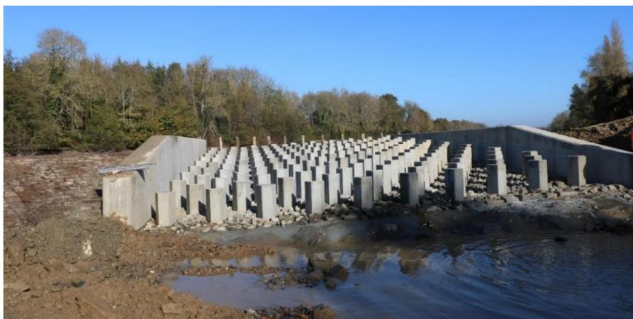
Figure 71 : Passe à poissons en enrochements en cours de travaux à Chambellay sur la Mayenne (source : D. Maffre-EP Loire)
