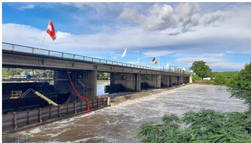
**Figure 137 : Rupture de clapet n°6 du pont barrage de Vichy sur l'Allier le 28 juin 2021**
