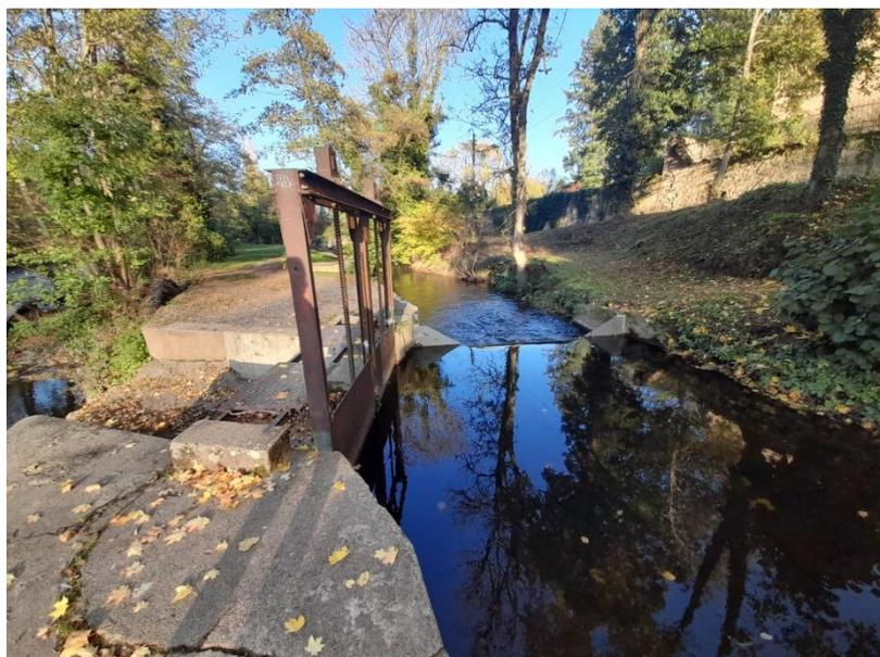
**Figure 321 : Ouvrage de limitation du débit du Béal à l'étiage installé en 2021 (Crédit : LOGRAMI)**
