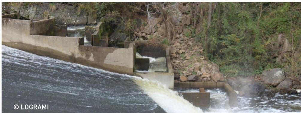
Figure 115: Passe à poisson de Chambezon correctement alimenté le 7/11/2014
