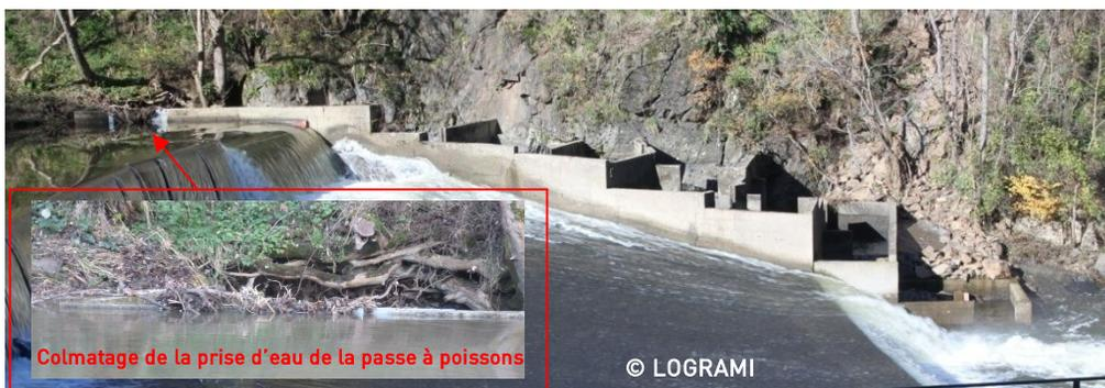
Figure 116: Passe à poisson de Chambezon colmaté le 21/11/2014
