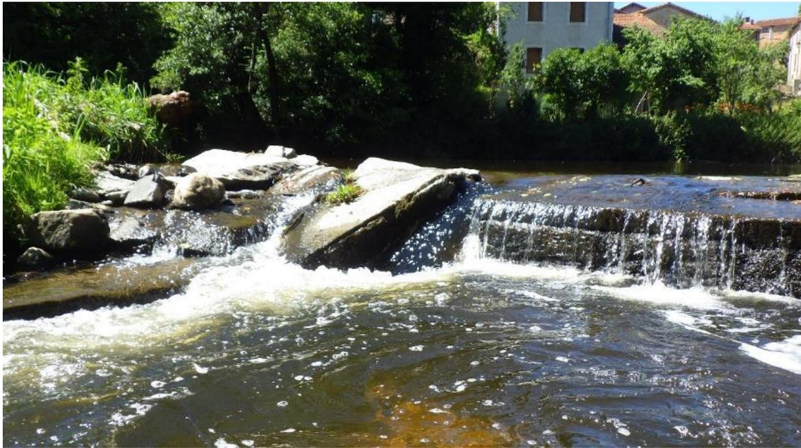
Photographie d'un seuil de la Sénouire (ROE10175) à Lavaudieu. Ce seuil vétuste est partiellement continu mais présente une hauteur de chute supérieure à 60 cm. La largeur de cet ouvrage (environ 2 m) entraîne des difficultés de franchissement par saut dans les conditions d'étude bien que celui-ci soit pourvu d'une fosse d'appel. Ce seuil est potentiellement problématique pour les saumons et est utilisé pour le découpage de la rivière en tronçons.
