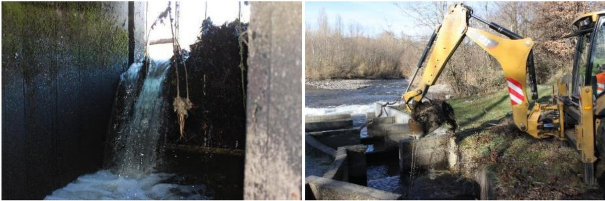
Figure 114 : Colmatage de l'entrée amont de la passe à poissons du barrage (à gauche) et intervention de la Mairie de Langeac pour nettoyer la passe à poissons ainsi que son entrée (à droite)
