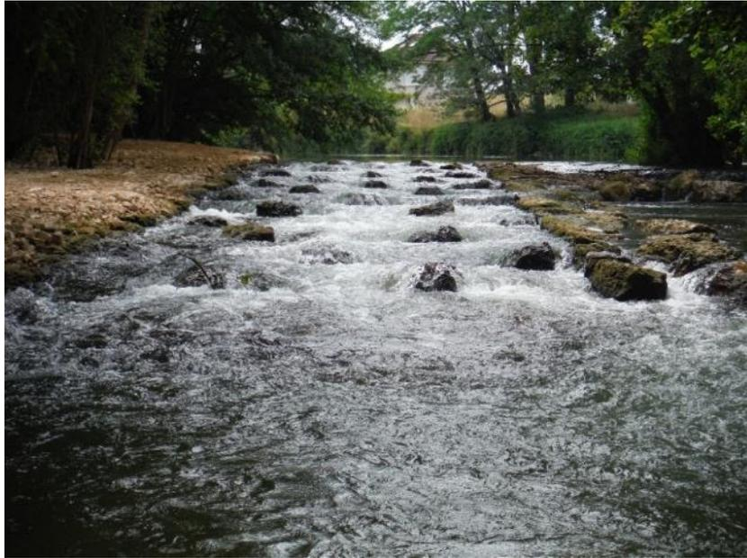
**Figure 89 : Passe en enrochements régulièrement répartis sur le seuil du Moulin de Souhé, Clain (© LOGRAMI)**
