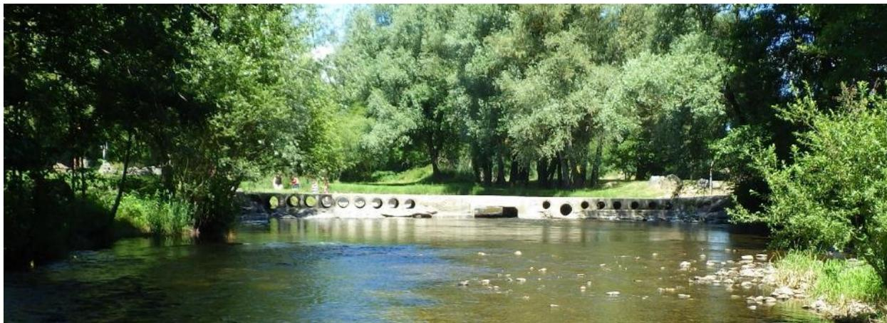
Photographie d'un seuil de la Sénouire (ROE10178) au niveau de Lavaudieu. Il est percé régulièrement de buses et d'une ouverture centrale offrant un continuum longitudinal optimal du cours d'eau. Ce seuil est non continu, et présente une hauteur de chute inférieure à 30 cm. Il n'est donc pas utilisé dans la segmentation du cours d'eau car ne présente pas de difficulté de franchissement pour les saumons atlantiques.
