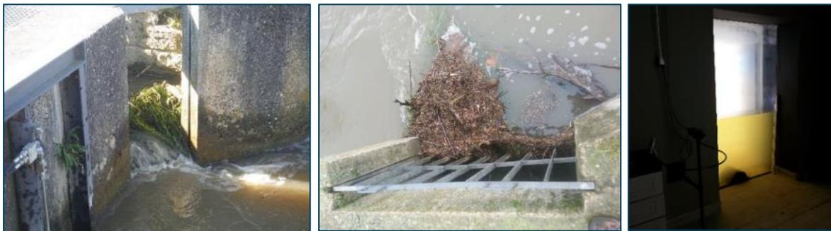
**Figure 110 : Photographies illustrant les défauts d'entretien de la passe à poissons du barrage de Descartes en 2016**
