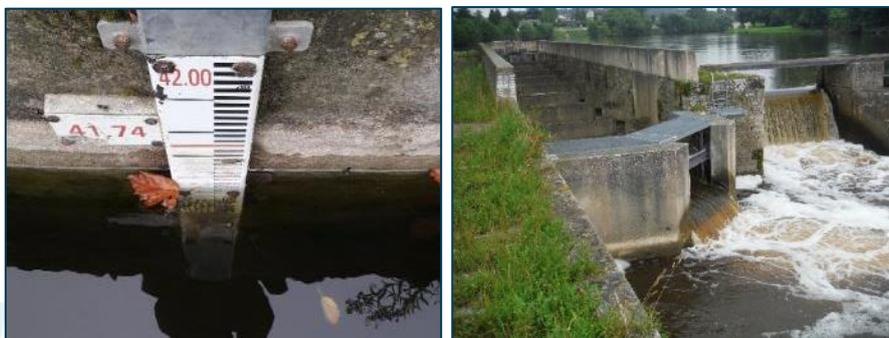
Figure 109 : Photographies illustrant les défauts de gestion du barrage de Descartes en 2016 : côte du plan d'eau plus basse que la côte légale (à gauche) et faible attractivité de l'entrée piscicole de la passe à poissons (à droite)
