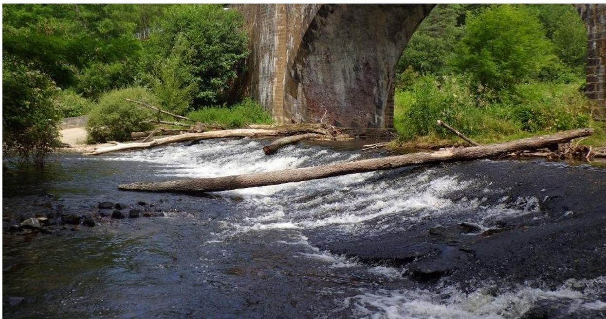
Photographie d'un seuil de la Sénouire (ROE10180) au niveau de Blannat. Ce seuil est continu et présente une hauteur de chute de 0,9 m (source Agence de l'eau). Il est donc utilisé pour la segmentation en tronçons car il est potentiellement problématique pour les saumons s'il n'est pas équipé de passe à poisson fonctionnelle.
