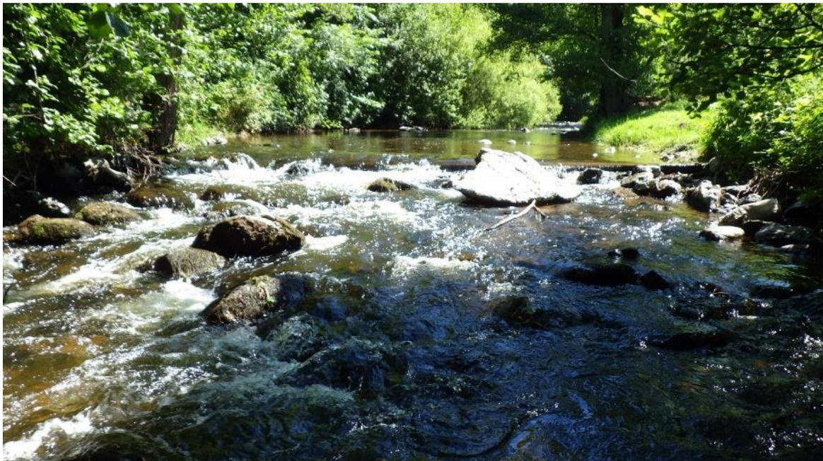
Photographie d'un seuil de la Sénouire (ROE10317). Ce seuil est partiellement continu et présente une hauteur de chute inférieure à 50 cm. Il ne présente pas de fosse d'appel mais est facilement franchissable au niveau de la brèche en rive droite qui diminue la hauteur de chute.
