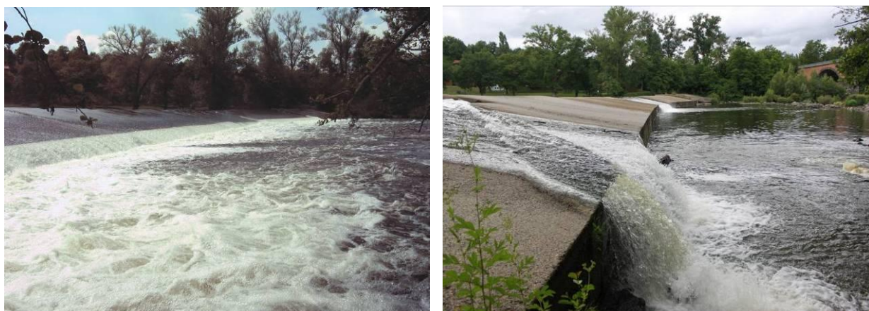
Figure 52 : Barrage de La Bageasse : A gauche le 18-05-2010 (débit 59 m 3 /s) ; A droite le 16-06-2011 (débit 5 m 3 /s). (Sources : LOGRAMI et Banque Hydro)
