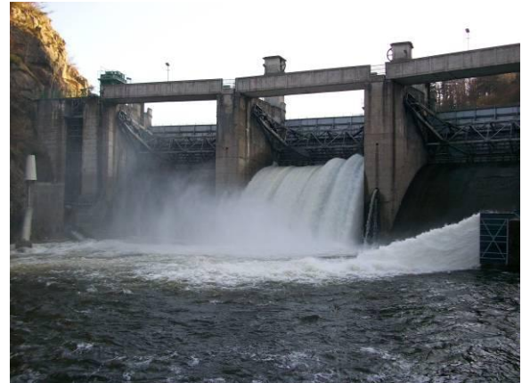
Figure 77 : Déversements au Barrage de Poutès. A gauche le 19/05/1999 (déversement barrage environ 300 m 3 /s). A droite le 16/03/2009 (déversement 16 m 3 /s). (Sources : LOGRAMI et EDF)
