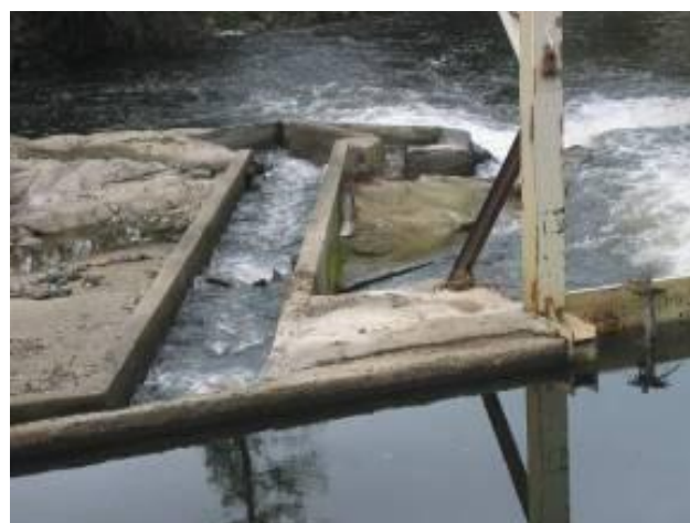
Figure 128 : Passe à poisson du barrage de Moulin Grand sous alimentée : à gauche le 9-10-2009 (débit journalier Joursac 1,65 m 3 /s) ; à droite le 24-10-2009 (débit journalier Joursac 1,7 m 3 /s) (Source : LOGRAMI)
