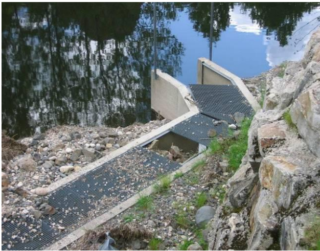
Figure 74 : Canal reliant la passe à poisson au Vieil Allier obstrué après la crue de novembre 2008 (Sources : LOGRAMI)
