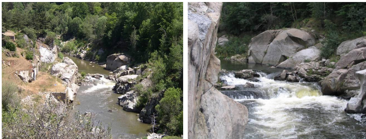
Figure 91 : Seuil au niveau de l'ancien barrage de Saint Etienne du Vigan. (Sources : LOGRAMI)
