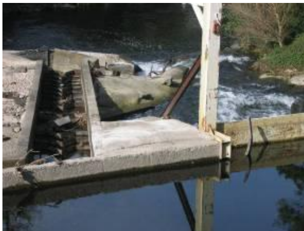
Figure 127 : Passe à poisson du barrage de Moulin Grand non alimentée : à gauche le 12-10-2009 (débit journalier Joursac 1,22 m 3 /s) ; à droite le 19-10-2009 (débit journalier Joursac 0,94 m 3 /s) (Source : LOGRAMI)
