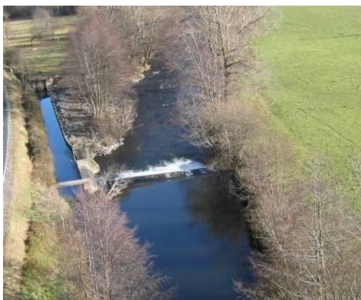
Figure 133 : Barrage des Italiens et canal d'amenée (à gauche) (Source : LOGRAMI)
