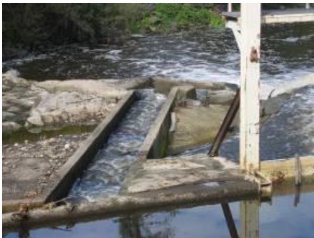
Figure 128 : Passe à poisson du barrage de Moulin Grand sous alimentée : à gauche le 9-10-2009 (débit journalier Joursac 1,65 m 3 /s) ; à droite le 24-10-2009 (débit journalier Joursac 1,7 m 3 /s) (Source : LOGRAMI)
