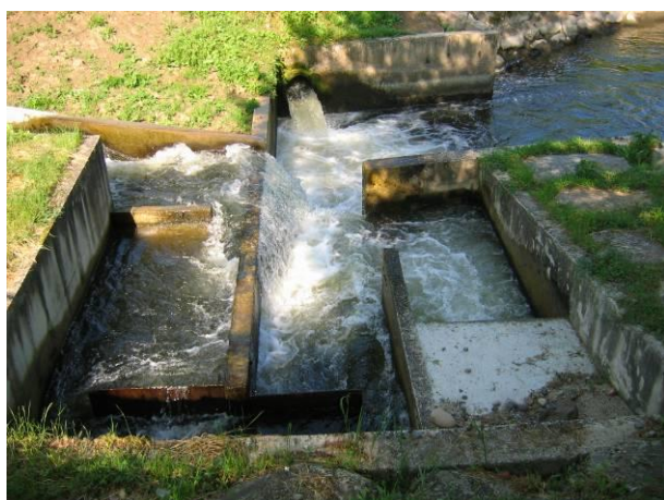
Figure 70 : Passe à poissons de l'usine de Langeac. En haut partie amont de la passe, en bas bassins et chute aval (Sources : LOGRAMI)
