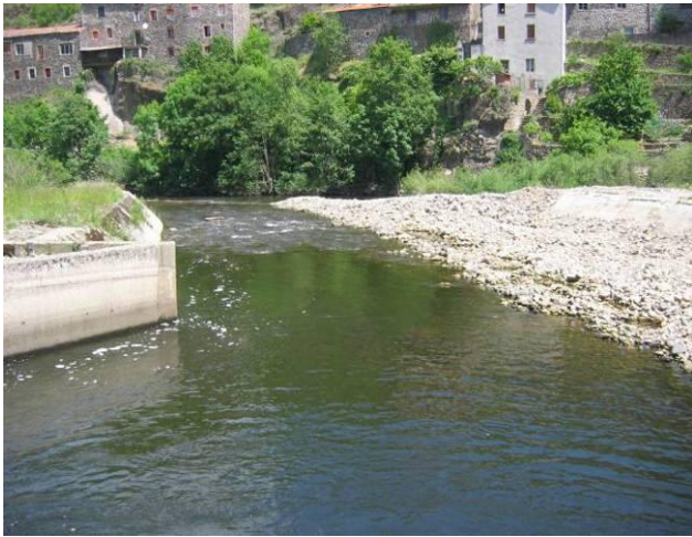
Figure 73 : Canal de fuite de l'usine de Monistrol (à gauche). Entrée de la passe à poissons au pieds des turbines (à droite) (Sources : LOGRAMI)
