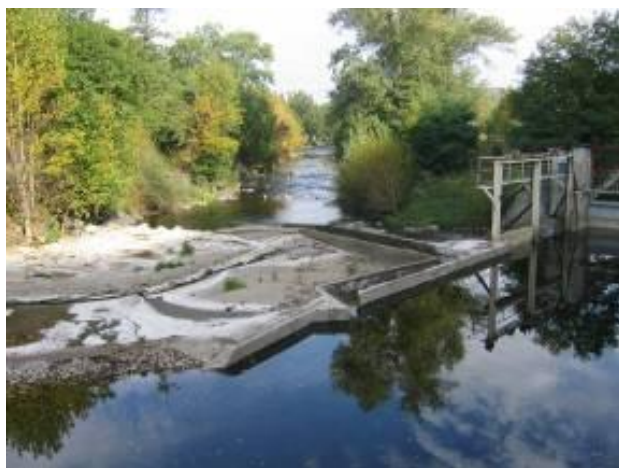
Figure 126 : Passe à poisson du barrage de Moulin Grand non alimentée le 5-10-2009 (débit journalier Joursac 0,74 m 3 /s) (Source : LOGRAMI)
