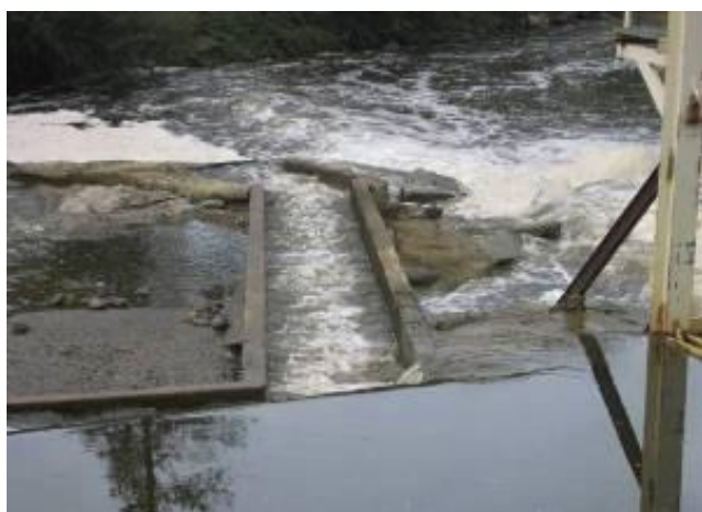
Figure 129 : Passe à poisson du barrage de Moulin Grand sur alimentée : à gauche le 22-10-2009 (débit journalier Joursac 3,38 m 3 /s, maxi horaire 12 m 3 /s) ; à droite le 26-10-2009 (débit journalier Joursac 1,6 m 3 /s) (Source : LOGRAMI)
