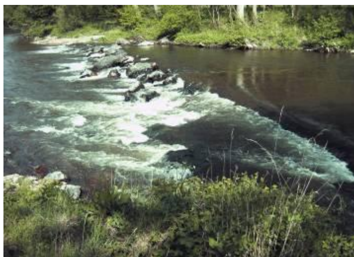
Figure 112 : Barrage des Trois eaux le 18 mai 2010 (débit Lempdes 10 m 3 /s) (Source : LOGRAMI)
