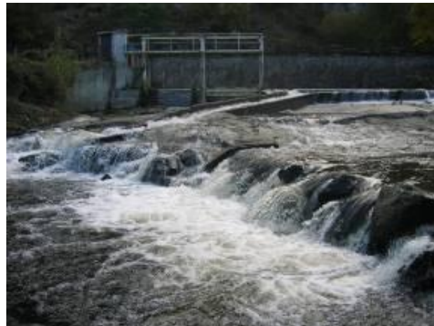
Figure 129 : Passe à poisson du barrage de Moulin Grand sur alimentée : à gauche le 22-10-2009 (débit journalier Joursac 3,38 m 3 /s, maxi horaire 12 m 3 /s) ; à droite le 26-10-2009 (débit journalier Joursac 1,6 m 3 /s) (Source : LOGRAMI)
