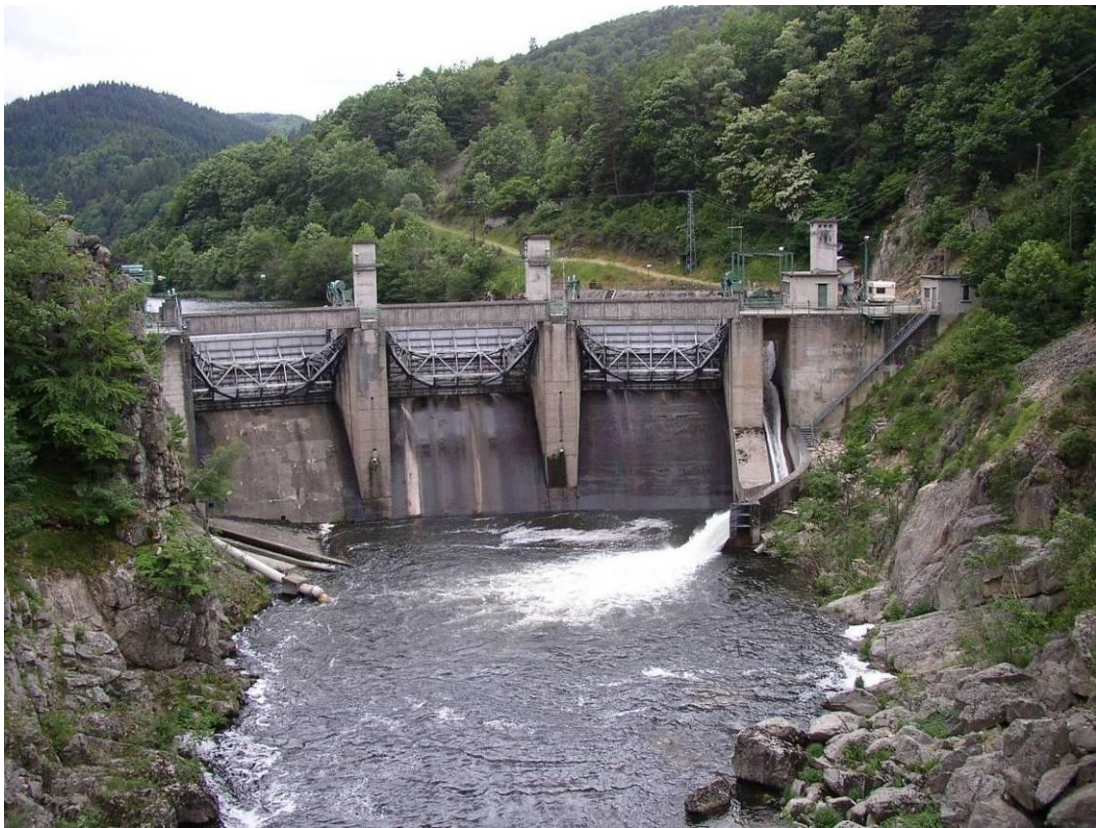
Figure 76 : Barrage de Poutès le 13/06/2004 (débit rive droite 2 m 3 /s par exutoire de dévalaison et 0,5 m 3 /s par passe à poisson rive gauche) (Source : LOGRAMI)
