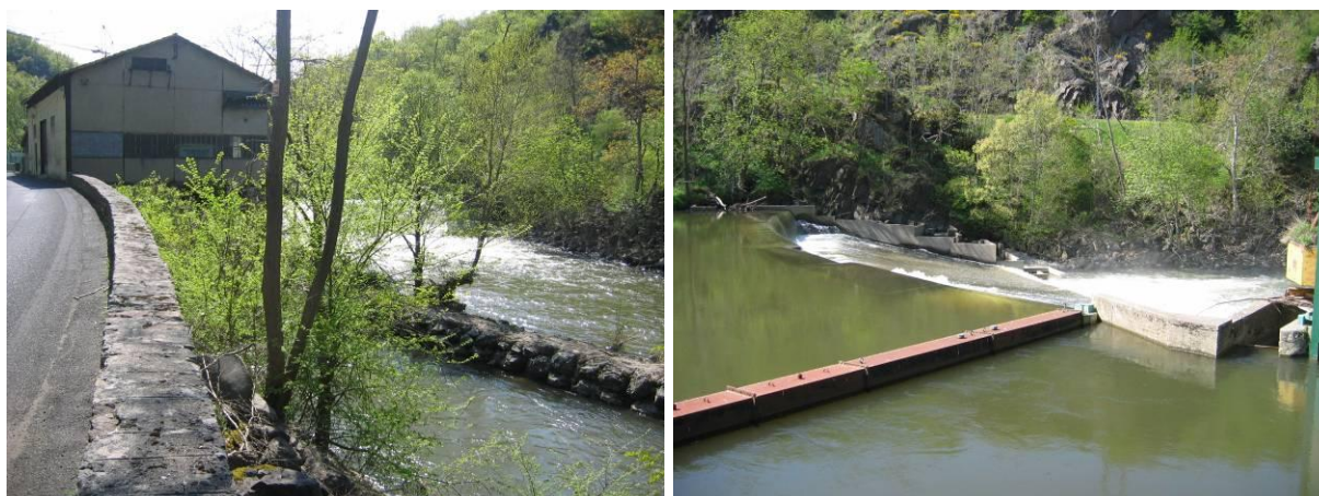
Figure 109: Usine et canal de fuite de Chambezon (à gauche) ; barrage et passe à poissons (à droite)
