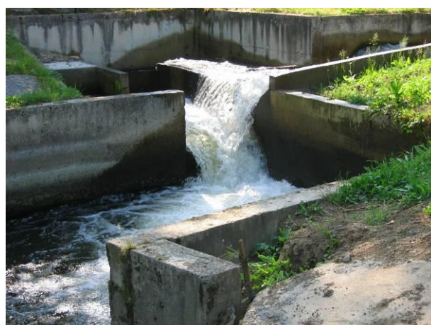
Figure 70 : Passe à poissons de l'usine de Langeac. En haut partie amont de la passe, en bas bassins et chute aval (Sources : LOGRAMI)
