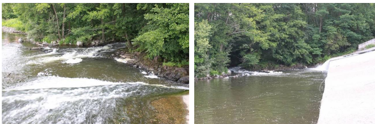
Figure 53 : Entrée de la passe à poisson (le 16-06-2011 débit 5 m 3 /s). (Sources : LOGRAMI et Banque Hydro)
