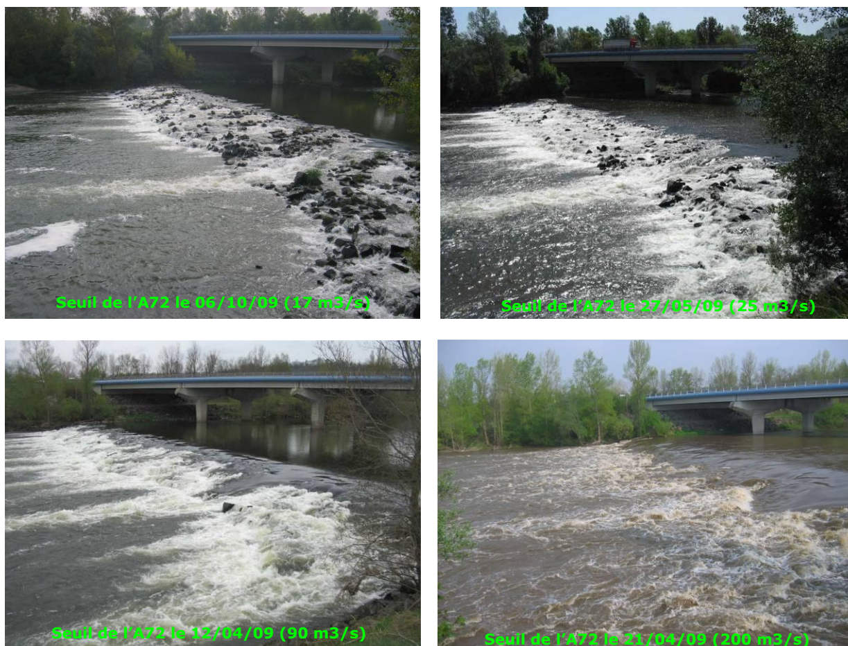
Figure 39 : Seuil de l'A72 à différents débits
