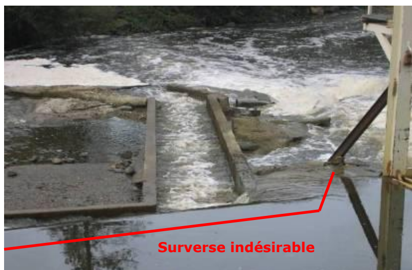
Figure 124 : Suralimentation de la passe à poisson du barrage de Moulin Grand observée le 22-10-2009 (débit journalier Joursac 3,38 m 3 /s, maxi horaire 12 m 3 /s) (Source : LOGRAMI)
