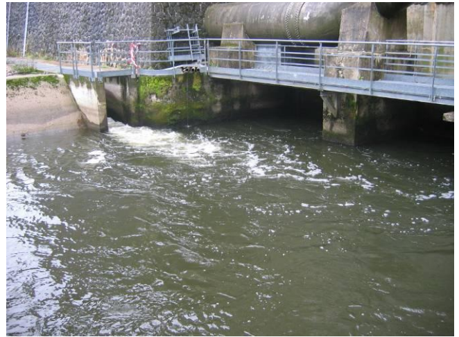
Figure 73 : Canal de fuite de l'usine de Monistrol (à gauche). Entrée de la passe à poissons au pieds des turbines (à droite) (Sources : LOGRAMI)
