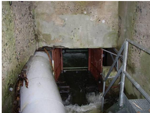
Figure 80 : Passe à poissons de Poutès. A gauche partie aval (passe à ralentisseur chevrons). A droite derniers bassins et entrée dans la cage de l'ascenseur. (Sources : LOGRAMI)
