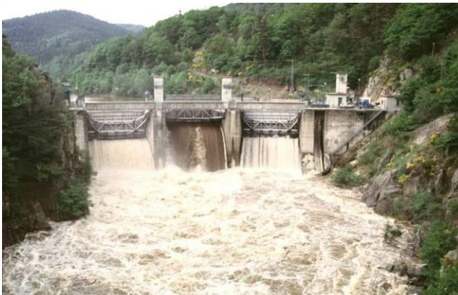
Figure 77 : Déversements au Barrage de Poutès. A gauche le 19/05/1999 (déversement barrage environ 300 m 3 /s). A droite le 16/03/2009 (déversement 16 m 3 /s). (Sources : LOGRAMI et EDF)
