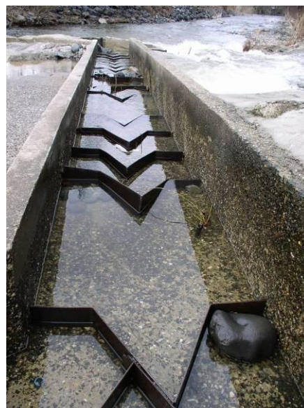
Figure 123 : Dégradations observées le 5-10-2009 sur la passe à poisson du barrage de Moulin Grand alors non alimentée (débit journalier Joursac 0,74 m 3 /s) (Source : LOGRAMI)
