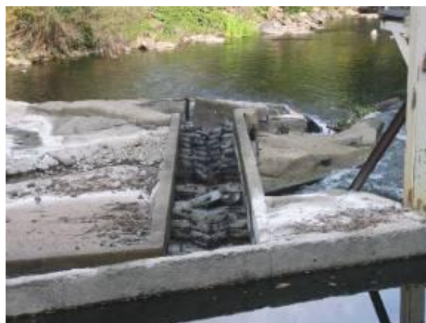
Figure 126 : Passe à poisson du barrage de Moulin Grand non alimentée le 5-10-2009 (débit journalier Joursac 0,74 m 3 /s) (Source : LOGRAMI)
