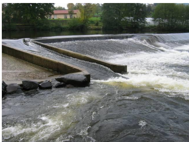
Figure 69 : Passe à canoës du barrage. A gauche le 03/11/2004 (débit 35,2 m 3 /s). A Droite le 26/05/2009 (débit 8,4m 3 /s) (Sources : LOGRAMI et Banque Hydro)
