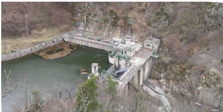
Figure 78 : barrage de Poutès et prise d'eau (Source : LOGRAMI)
