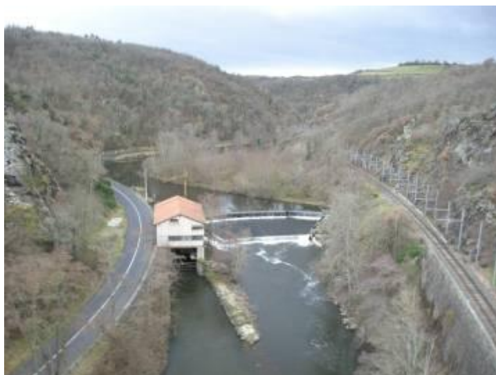
Figure 108 : Complexe hydroélectrique de Chambezon sur l'Alagnon le 7/12/2007 (débit à Lempdes 12 m 3 /s) (Source LOGRAMI)
