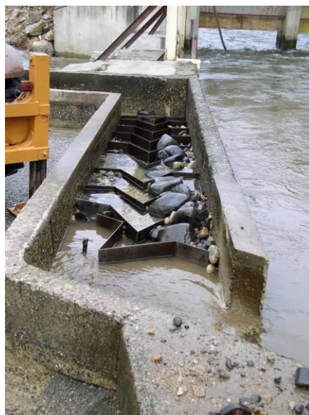
Figure 123 : Dégradations observées le 5-10-2009 sur la passe à poisson du barrage de Moulin Grand alors non alimentée (débit journalier Joursac 0,74 m 3 /s) (Source : LOGRAMI)
