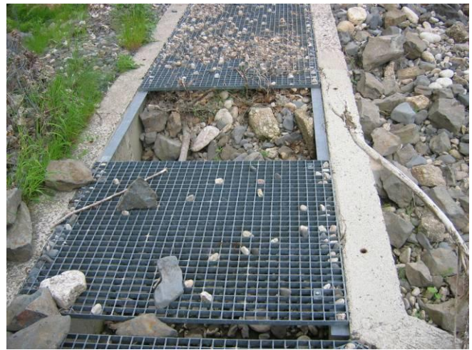
Figure 74 : Canal reliant la passe à poisson au Vieil Allier obstrué après la crue de novembre 2008 (Sources : LOGRAMI)
