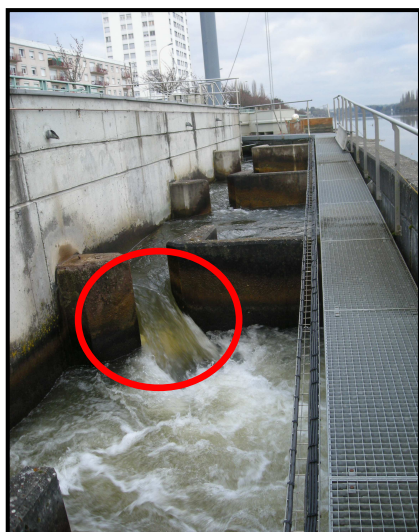
Echancrure bloquée par un embâcle plastique
