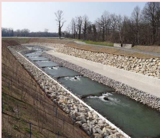
Dissipation par une succession de seuils (Source : www.hydrostadium.com )
