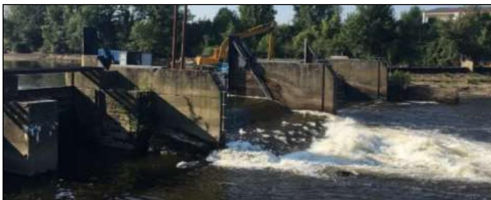
Figure 106 : Photographie des travaux sur le barrage de Descartes et de la mise à plat d'un des deux clapets (le 25 juillet 2018)
