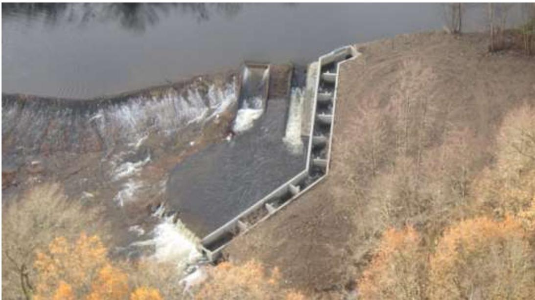
Figure 47 : Vue de dessus de la passe à bassins successifs réalisée à l'Usine de Neuvial (en rive gauche) sur la Sioule en 2018 (Source : LOGRAMI)
