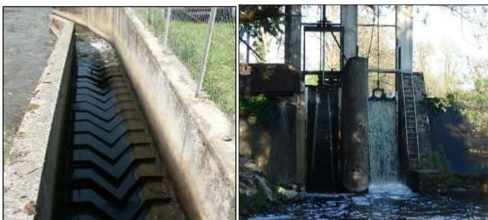
**Figure 77: Vue hors d'eau de la passe à poissons à ralentisseurs (à gauche) et de la vanne de décharge du débit réservé (à droite) de l'usine hydroélectrique du Moulin de Chaume**
