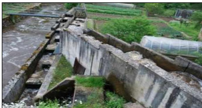
**Figure 72: Passe à poissons à bassins successifs installée au niveau de l'usine hydroélectrique de la Roche Etrangleloup sur la Gartempe**
