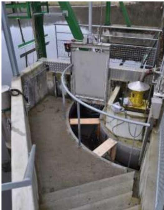
Figure 89: Vue amont des deux cadres des antennes RFID installées dans la goulotte de dévalaison de l'usine de la Roche Etrangleloup sur la Gartempe en 2018
