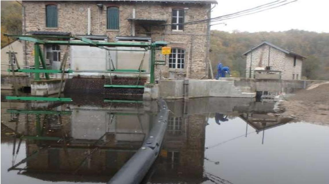
**Figure 100 : Vue amont de l'usine de la Roche Etrangleloup avec le plan de grille à gauche et l'entrée hydraulique de la passe à poissons à droite (Source : Logrami)**
