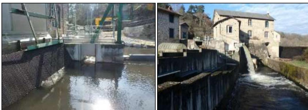
Figure 73 : Vues du plan de grilles fines et de l'exutoire de dévalaison (à gauche) et de la restitution de la goulotte de dévalaison (à droite) de l'usine de la Roche Etrangeloup sur la Gartempe
