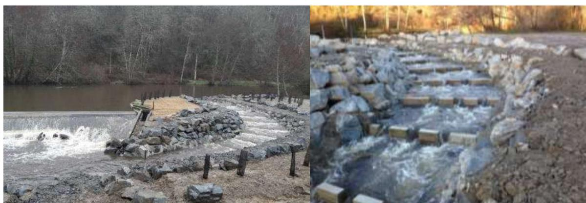
Figure 74 : Rivière de contournement à pré-barrages au niveau du seuil de l'usine hydroélectrique de Roche sur la Gartempe ; vue générale à gauche et détail des pré-barrages à droite (Sources : LOGRAMI et A. Lemoine-AFB)
