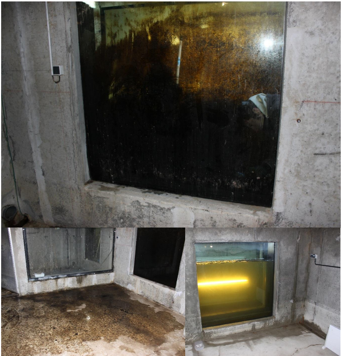
Figure 114 : Etapes de réhabilitation de la station de l'usine hydroélectrique du barrage de Langeac (Source : LOGRAMI)
