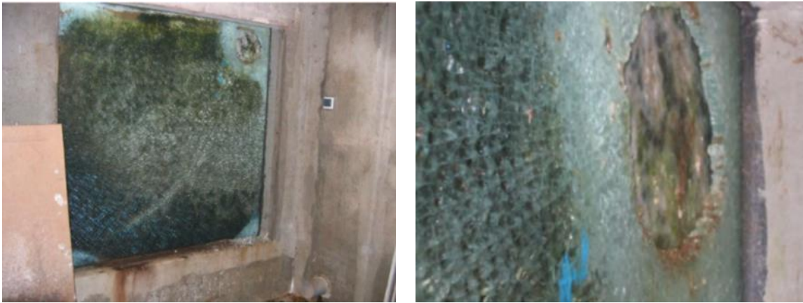
Figure 113 : Détérioration de la vitre de la station de comptage de l'usine hydroélectrique du barrage de Langeac (Source : LOGRAMI)
