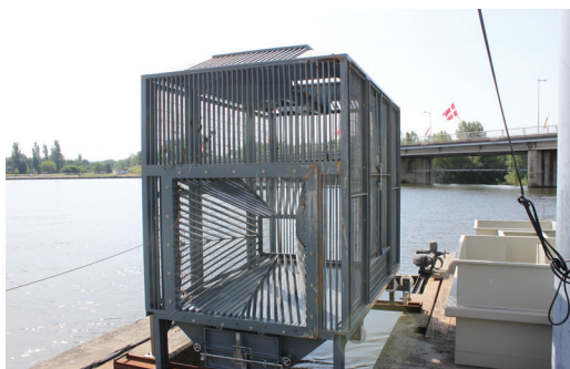
Système de piégeage dans la passe à poissons de Vichy
